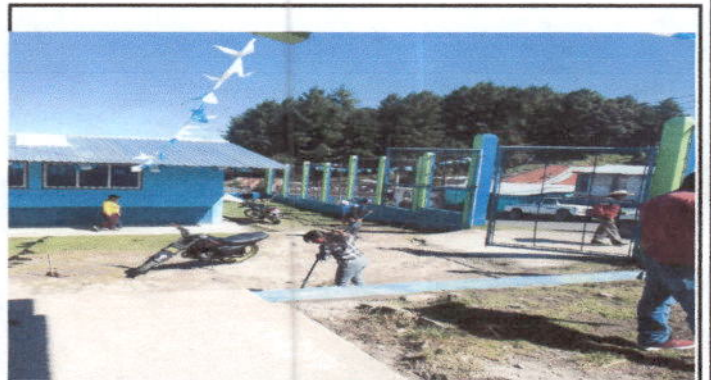
Foto 4: Reparación de planchas de concreto de patio
