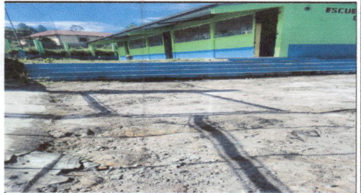
Foto 2: Reparación de planchas de concreto de patio
