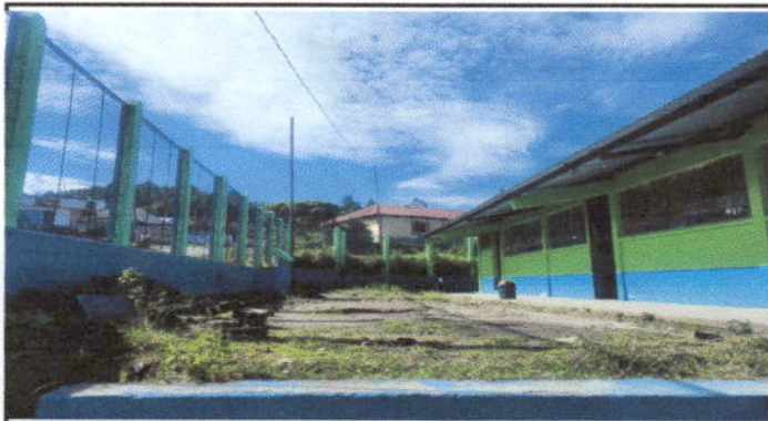
Foto 3: Reparación de planchas de concreto de patio
